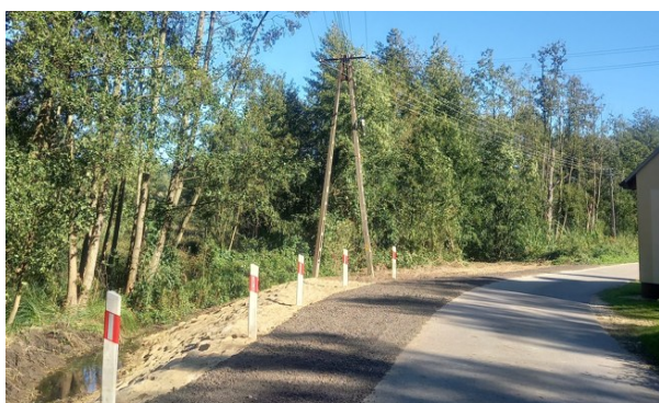
Pasieka Wałowska – umocnienie skarpy przy cieku wodnym
