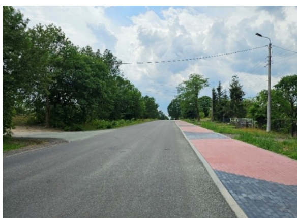
Konopnica - Droga gminna Nr 113132 E
