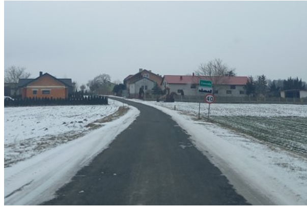
Zawady – zwalczanie śliskości poprzez posypanie nawierzchni mieszanką piasku i soli
