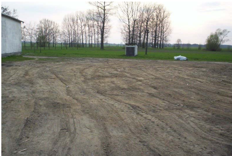
Zdjęcie 4. Teren po zasypnym zbiorniku przeciwpożarowym
