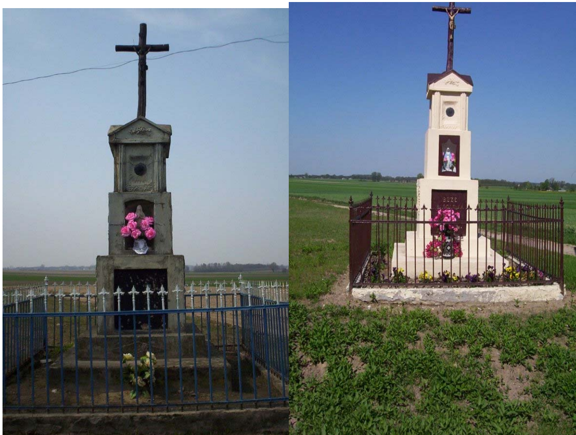
Zdjęcie 16 i 17. Kapliczka murowana przed i po remoncie
