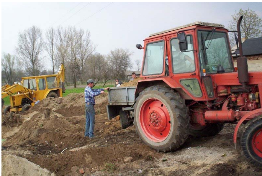
Zdjęcie 2. Zasypywanie zbiornika przeciwpożarowego przez mieszkańców wsi
