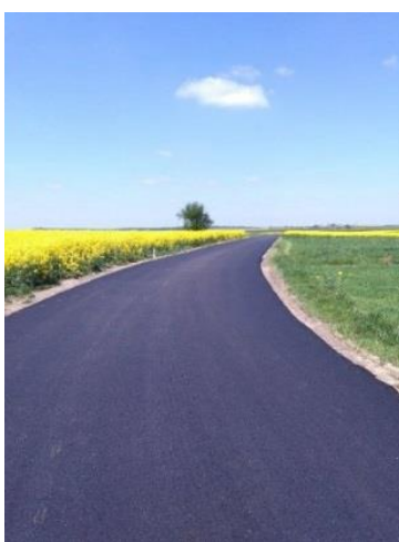
droga Nowa Rossocha – Zglinna Mała
